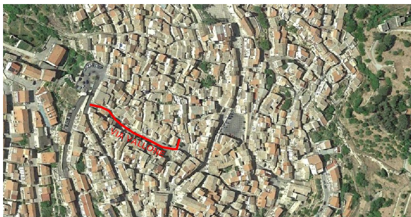
Foto satellitare individuazione dell'area d'intervento rispetto al centro storico di Assoro
