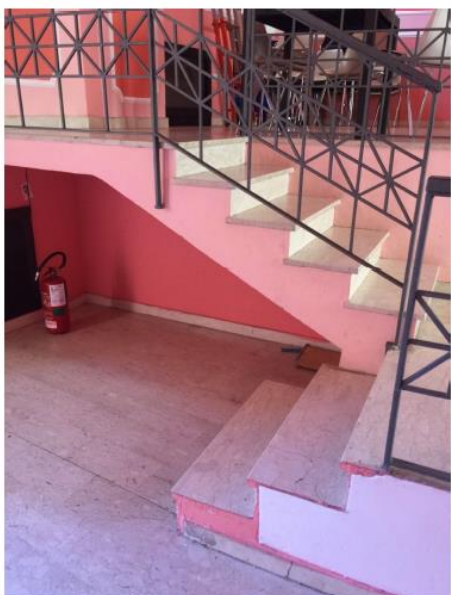
Foto 10 Sala Teatro particolare pavimentazione e scala di collegamento
