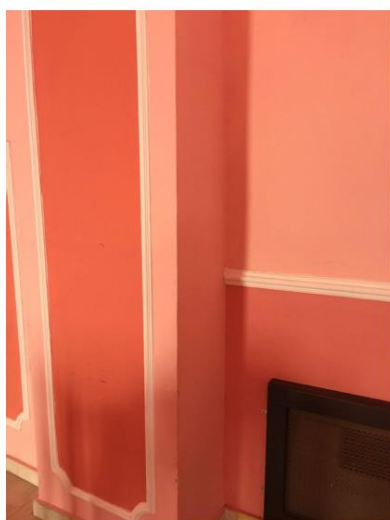
Foto 6 - particolare stucchi e rivestimenti pareti
