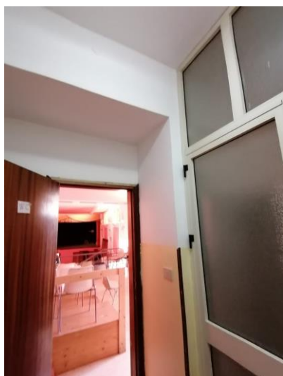
Foto 14 accesso al teatro dal lato interno
